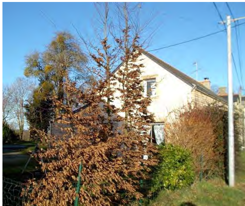
Photo 29 : la maison du Goulet Saint Jean
